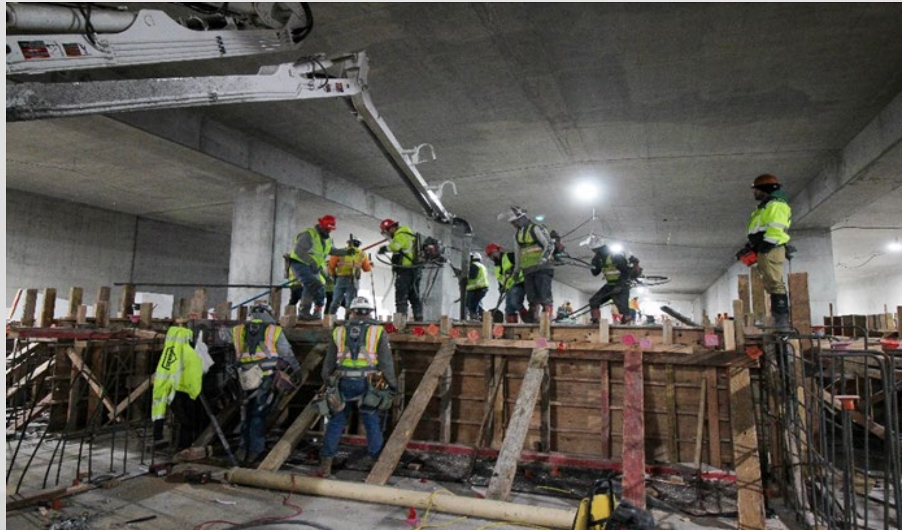
APM Platform Concrete Pour
