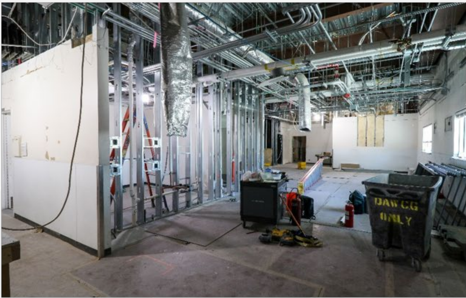
Bulletin 230 Skywest Framing & Drywall
