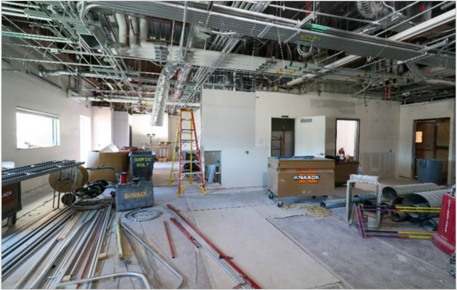
Bulletin 230 Skywest Ops Framing & Drywall
