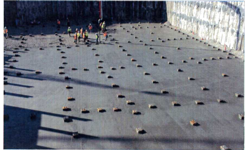
Mud slab pour in Terminal Basement Level 0.
