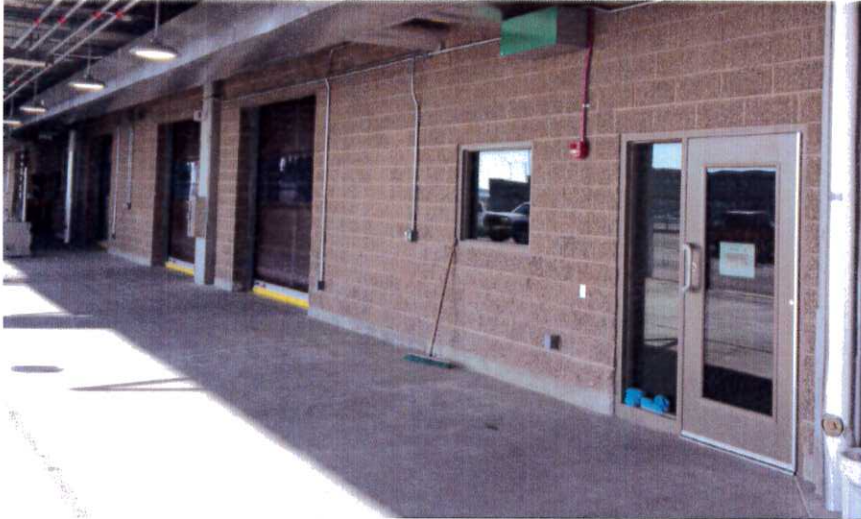
QTA Tenant entryway
