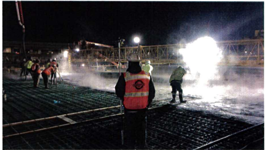
Elevated Roadway Bridge Concrete Pour
