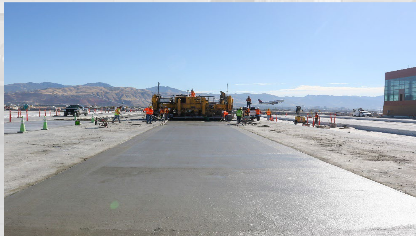
Paving Taxilane 2E
